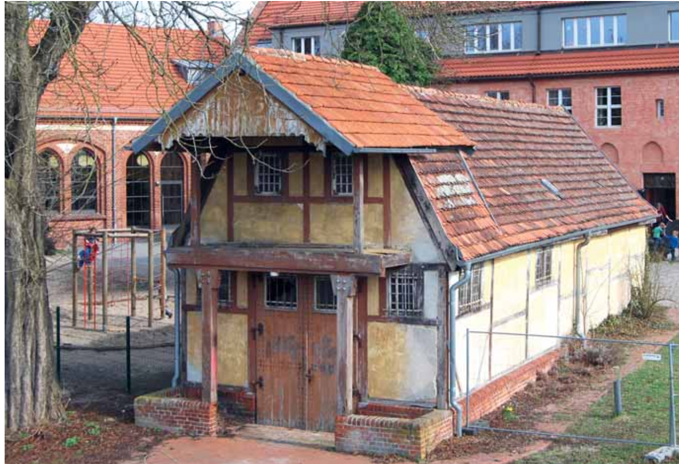
17 Bootshaus, Domstift Brandenburg, Ansicht von Norden. Foto: pmp Architekten, 2018.
