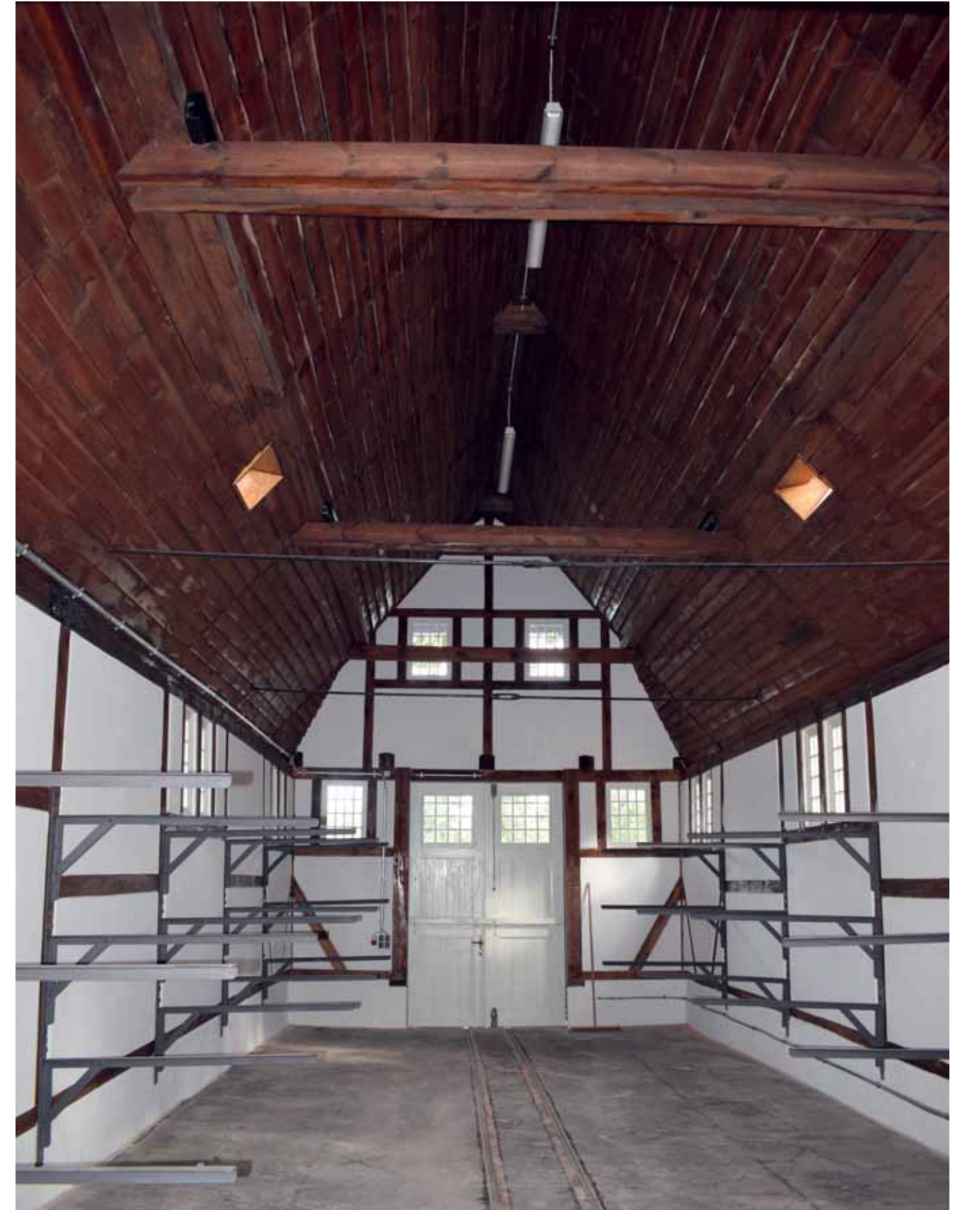
24 Bootshaus, Innenraum, Blick nach Norden, Zustand nach Fertigstellung. Foto: pmp Architekten, 2019.
