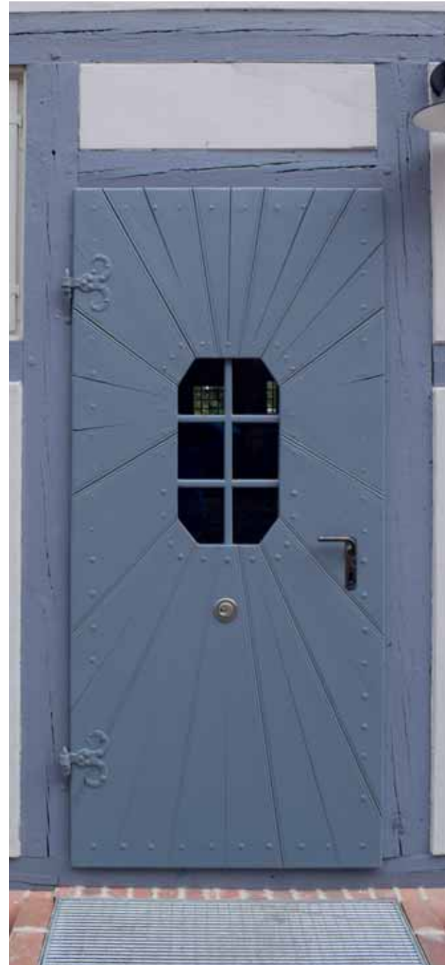
23 Eingangstür an der Südfassade, Zustand nach Fertigstellung. Foto: pmp Architekten, 2019.
