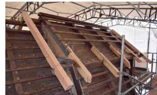
19 Reparaturen der Dachkonstruktion im Bereich des Mansarddaches. Foto: pmp Architekten, 2019.
