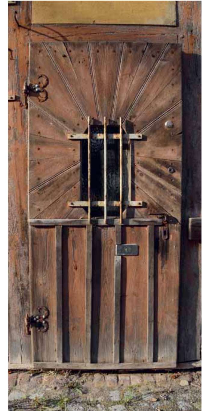
21 Eingangstür an der Südfassade des Bootshauses, aufgedoppelte Rahmentür. Teile der strahlenförmigen Aufdoppelung auf der Außenseite sind verloren gegangen. Foto: pmp Architekten, 2018.
